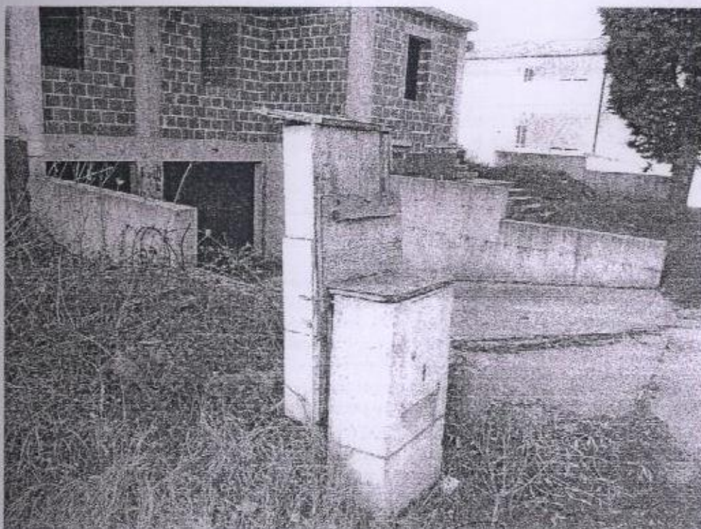
6. Slika 6. Gradilišni priključak na NN mrežu
